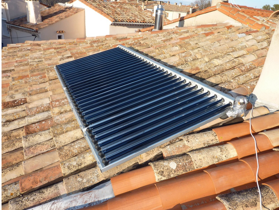
Capteurs ouest 75° sur le toit
